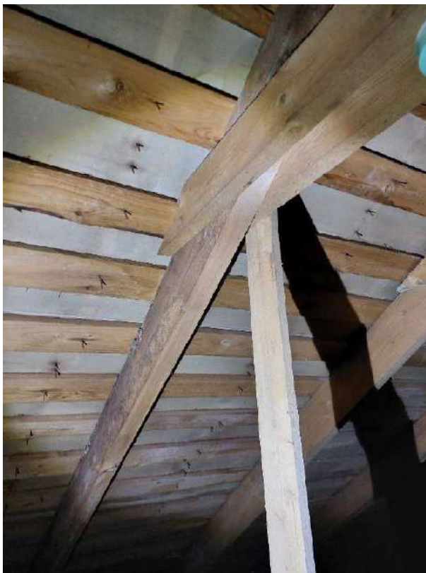
3 pav. Bendras pastogės medinių konstrukcijų vaizdas. Konstrukcijų ir sujungimų būklė gera
