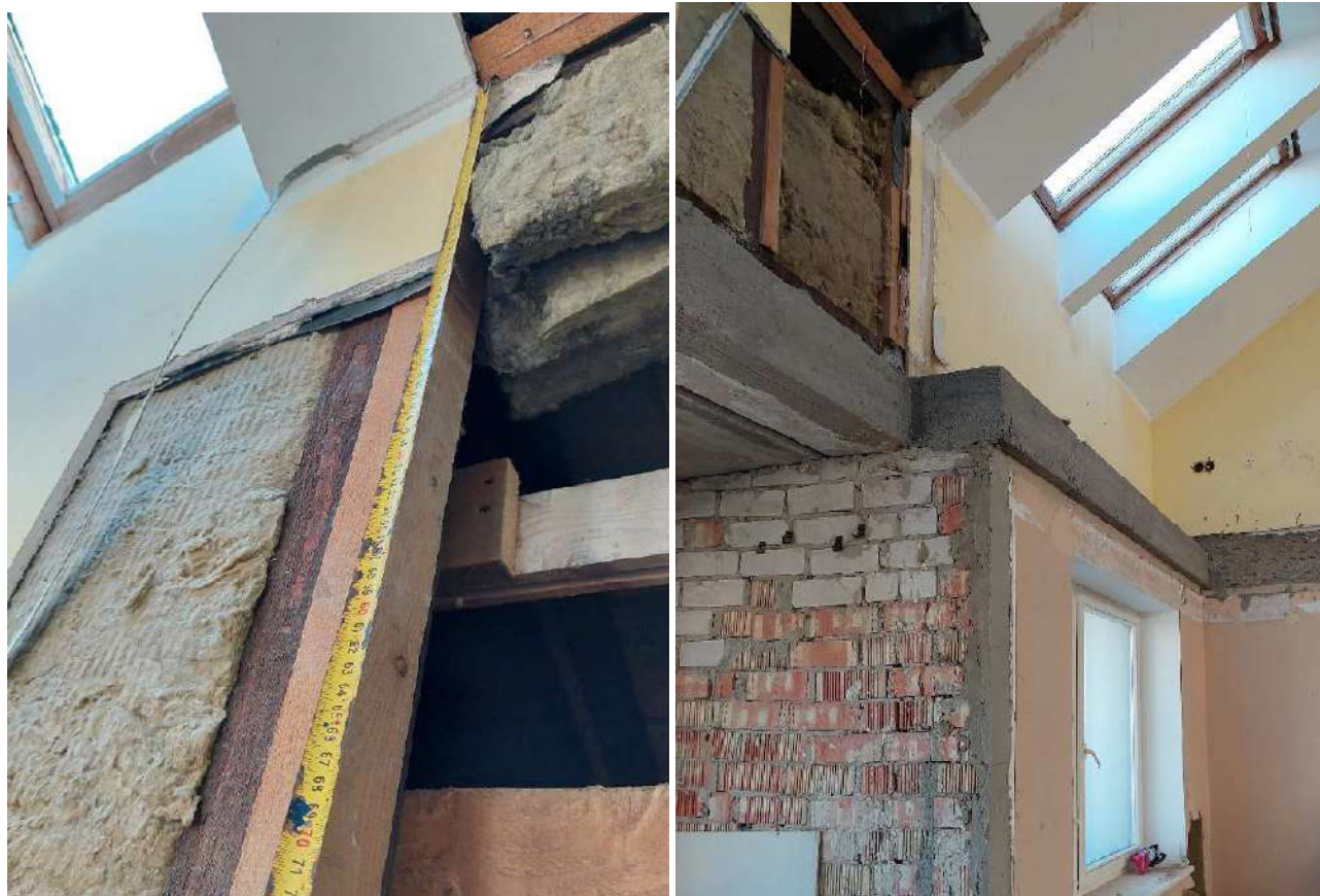
10 pav. Pastogės vertikali sienutė karnizo zonoje, virš balkono plokštės. Atidengti apdailos plotai, nuimtos šiltinimo plokštės, pažeista garo izoliacija
