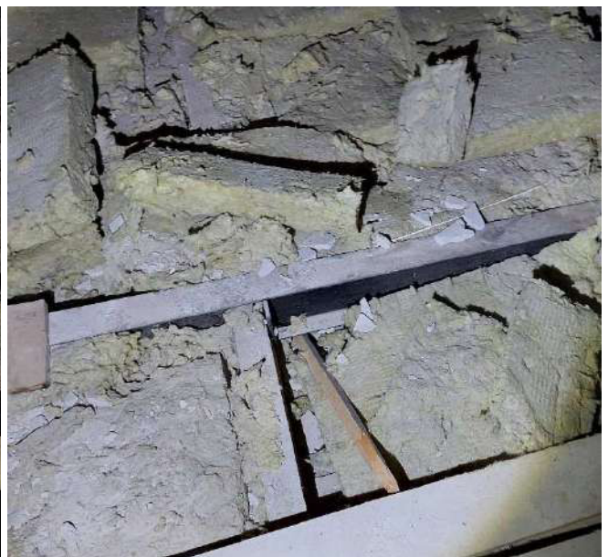
7 pav. Pastogės vaizdas kapitalinio remonto zonoje. Šiltinimo plokštės suktos netvarkingai. Matomi neapšiltinti plotai.
