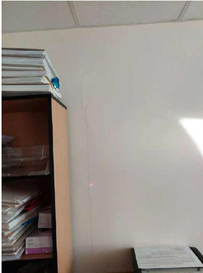
29 pav. 2 aukšto sienų vertikalūs plyšiai
