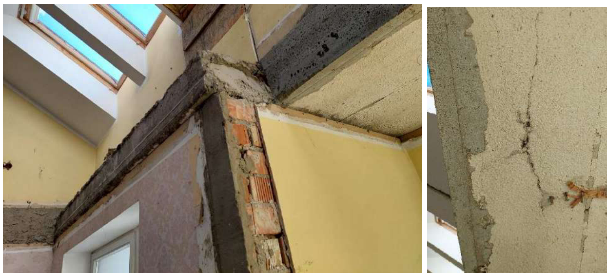
18 pav. 3 aukšto patalpos perdangų demontavimo metu išilgai nukirstos plokštės balkonų zonoje. Palikti siauri perdangos ruožai su išilginiais plyšiais. Zona „F“
