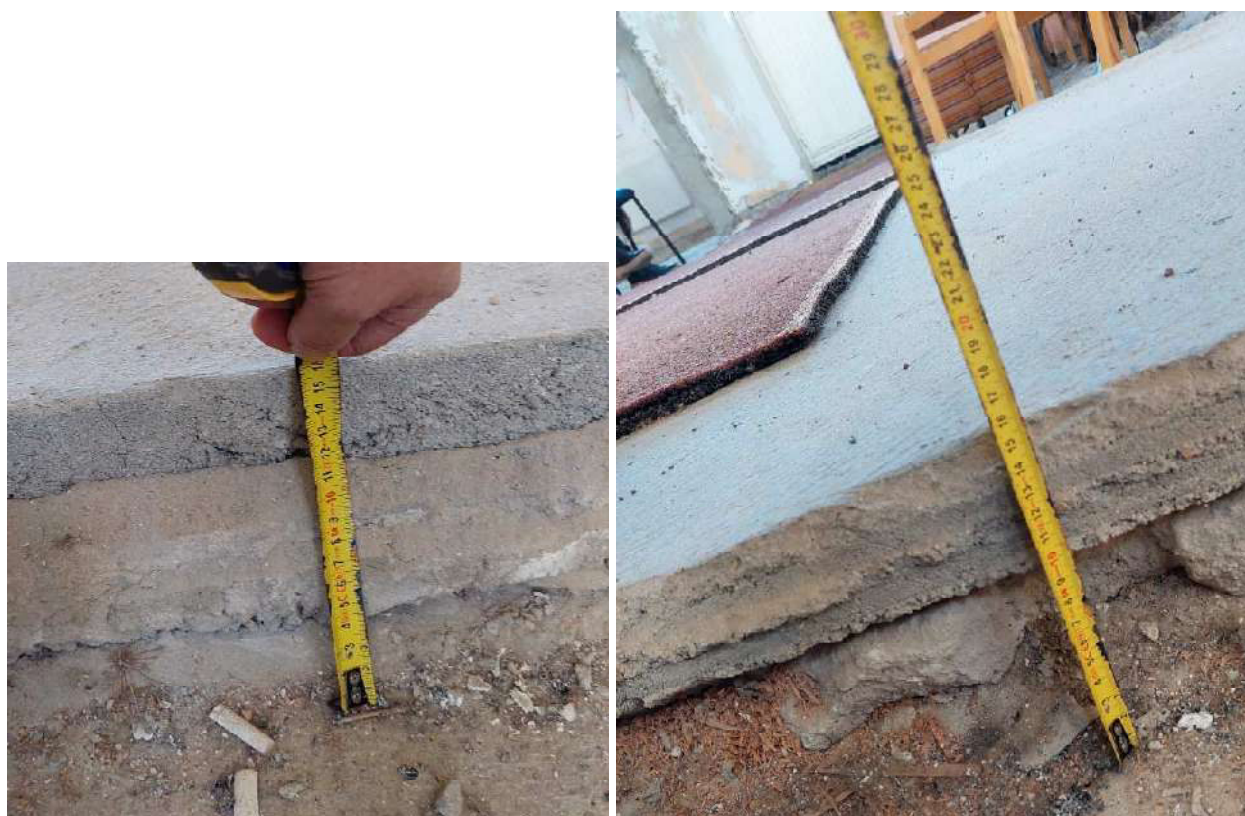
11 pav. 3 aukšto patalpos centrinės dalies grindų sluoksnio matavimai. Grindų storis 160mm
