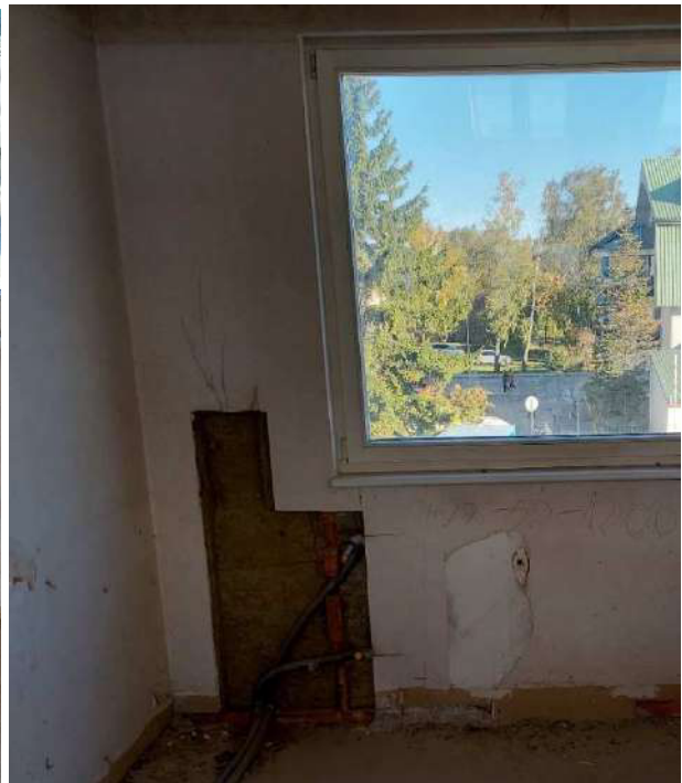
25 pav. Esamų fasadinių sienų konstrukcija medinė karkasinė
