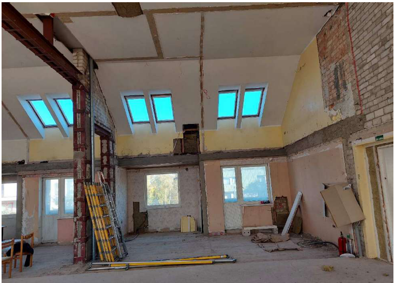
2 pav. Trečio aukšto salės bendras vaizdas su 2013m kapitalinio remonto metu demontuotomis perdangomis ir įrengtomis plieno konstrukcijomis
