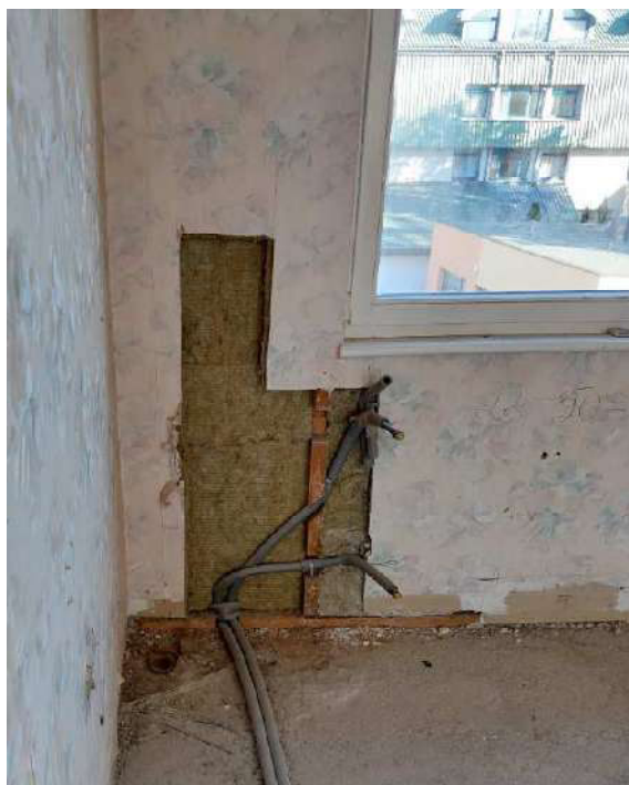
25 pav. Esamų fasadinių sienų konstrukcija medinė karkasinė
