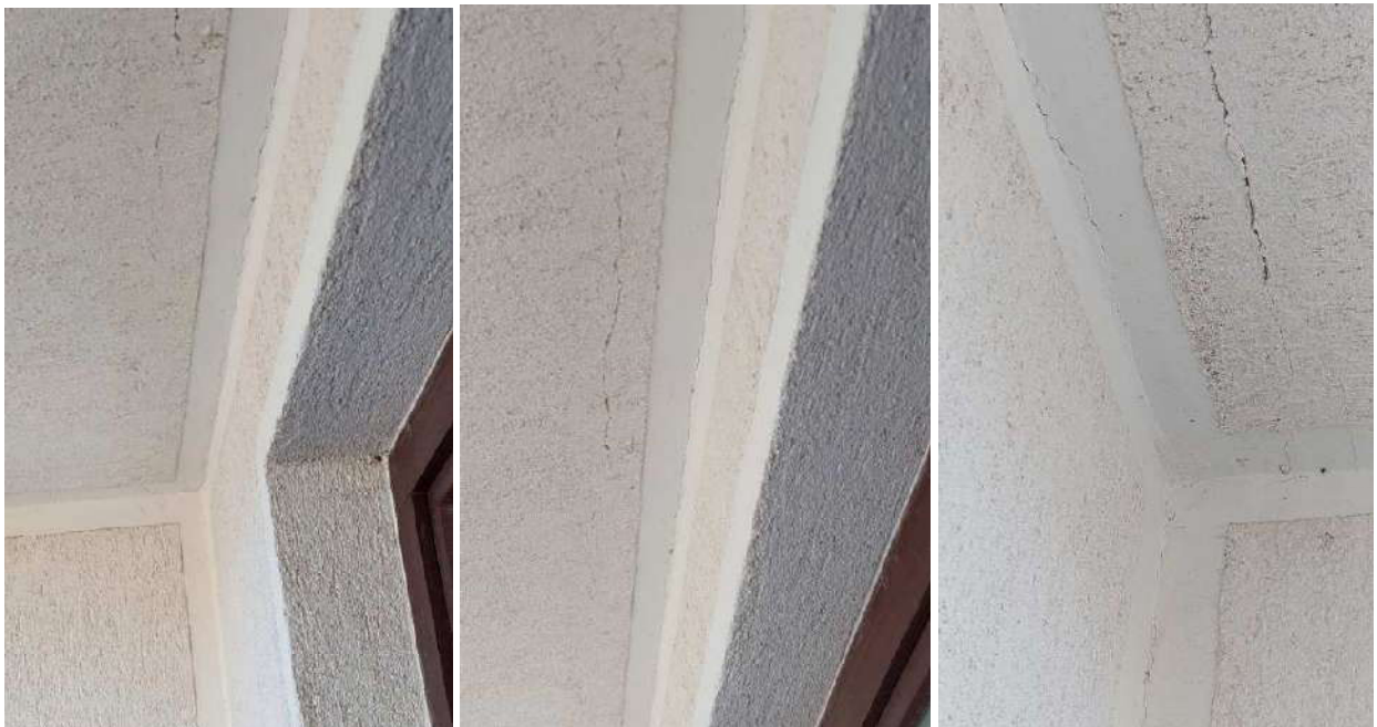
13 pav. 3 aukšto patalpos perdangų demontavimo metu išilgai nukirstos plokštės balkonų zonoje. Palikti siauri perdangos ruožai. Balkono išorėje matomi išilginiais plyšiais plokščių sandūroje. Zona „A“
