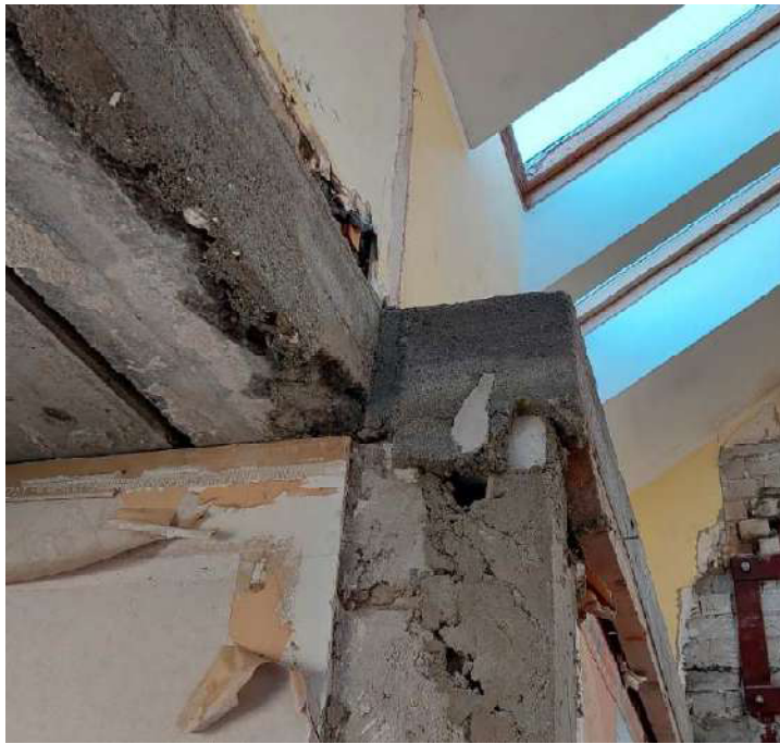
14 pav. 3 aukšto patalpos perdangų demontavimo metu išilgai nukirstos plokštės balkonų zonoje. Palikti siauri perdangos ruožai su išilginiais plyšiais. Zona „B“
