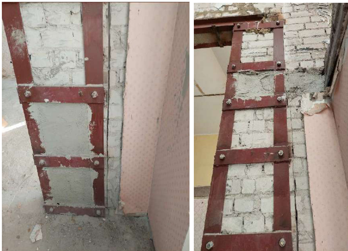
23 pav. Pastogės kapitalinio remonto metu įrengtos plieninės atramos, mūro stulpų aprėminimai. Mūro pjovimo vietose būtina numatyti apkabas surišimui su pagrindine siena
