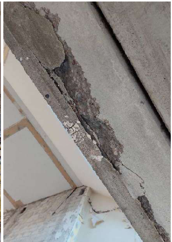
15 pav. 3 aukšto patalpos perdangų demontavimo metu išilgai nukirstos plokštės balkonų zonoje. Palikti siauri perdangos ruožai su išilginiais plyšiais. Zona „C“
