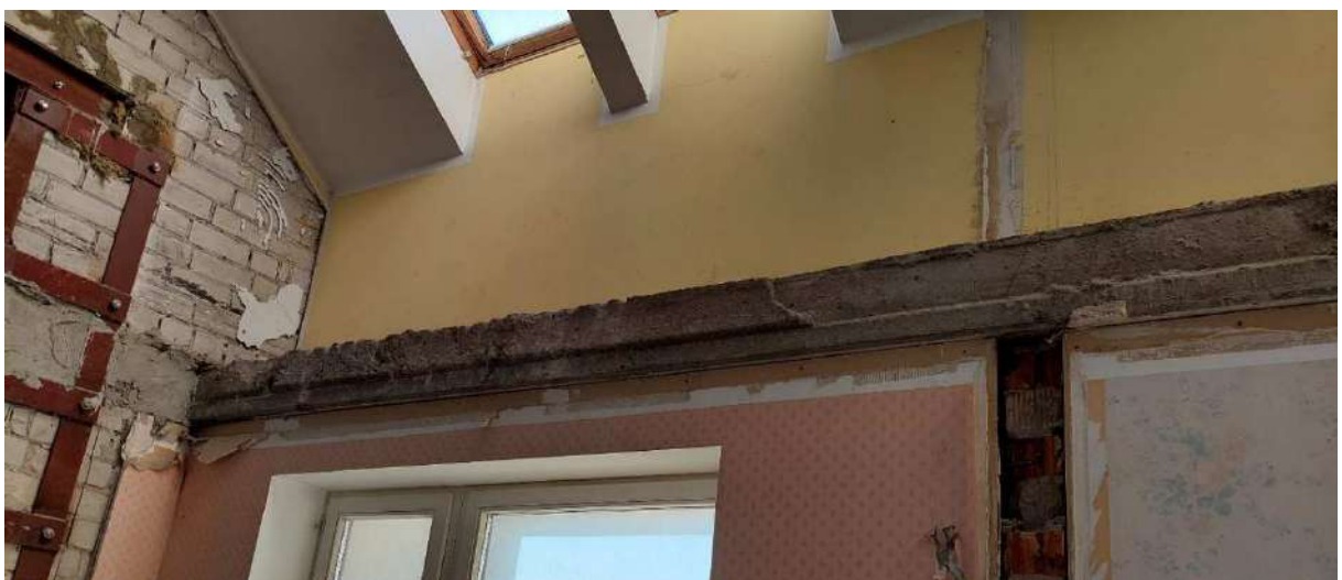
17 pav. 3 aukšto patalpos demontuotos perdangos iki balkono sienos. Zona „E“
