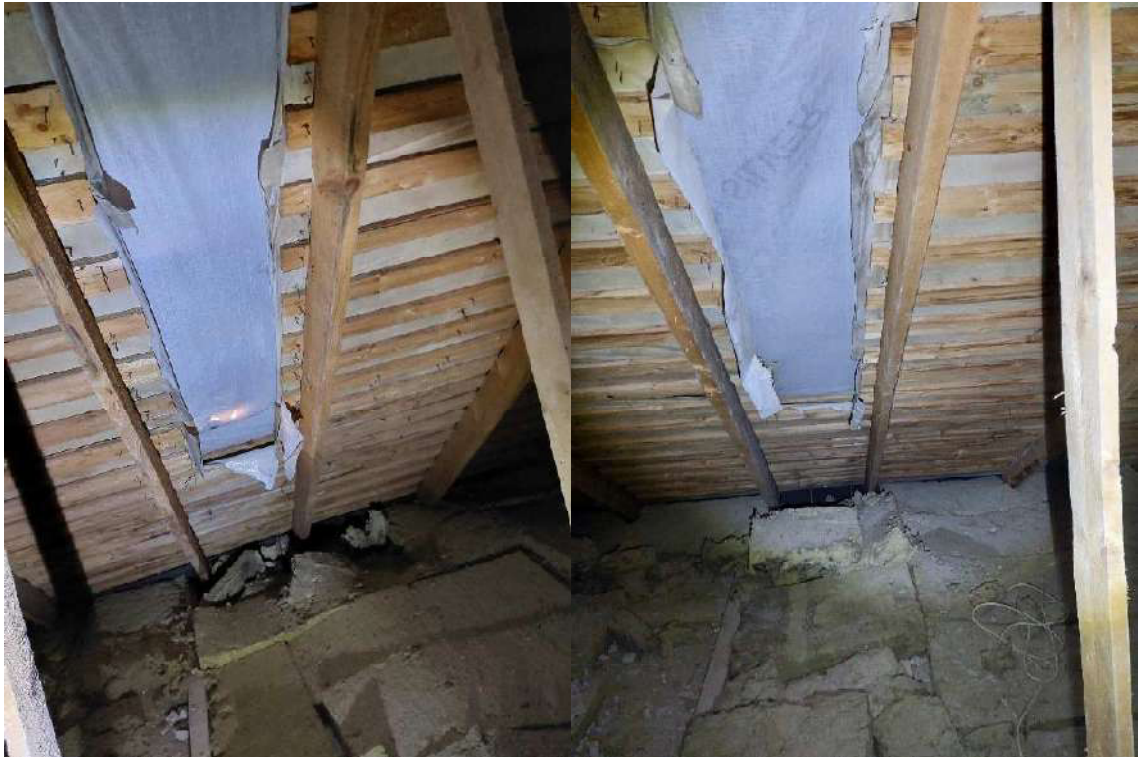
8 pav. Mūrinių vėdinimo ortakių demontavimo vietose neįrengti grebėstai stogo skardos atrėmimui
