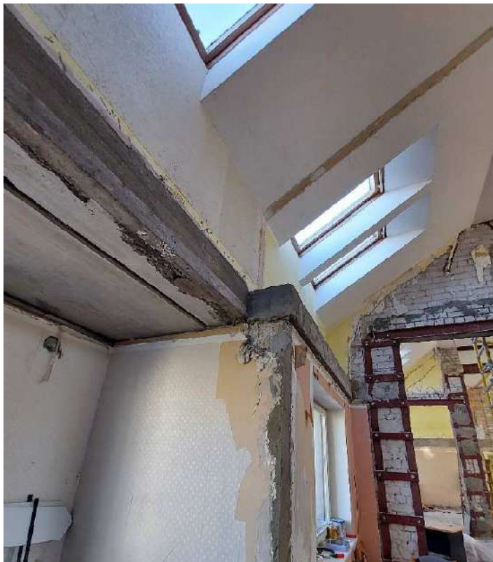
15 pav. 3 aukšto patalpos perdangų demontavimo metu išilgai nukirstos plokštės balkonų zonoje. Palikti siauri perdangos ruožai su išilginiais plyšiais. Zona „C“
