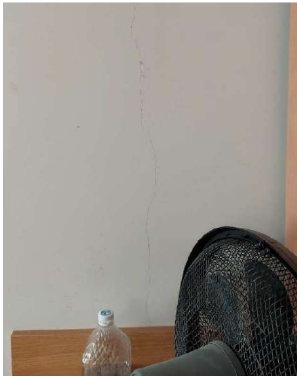
28 pav. 2 aukšto sienų vertikalūs plyšiai
