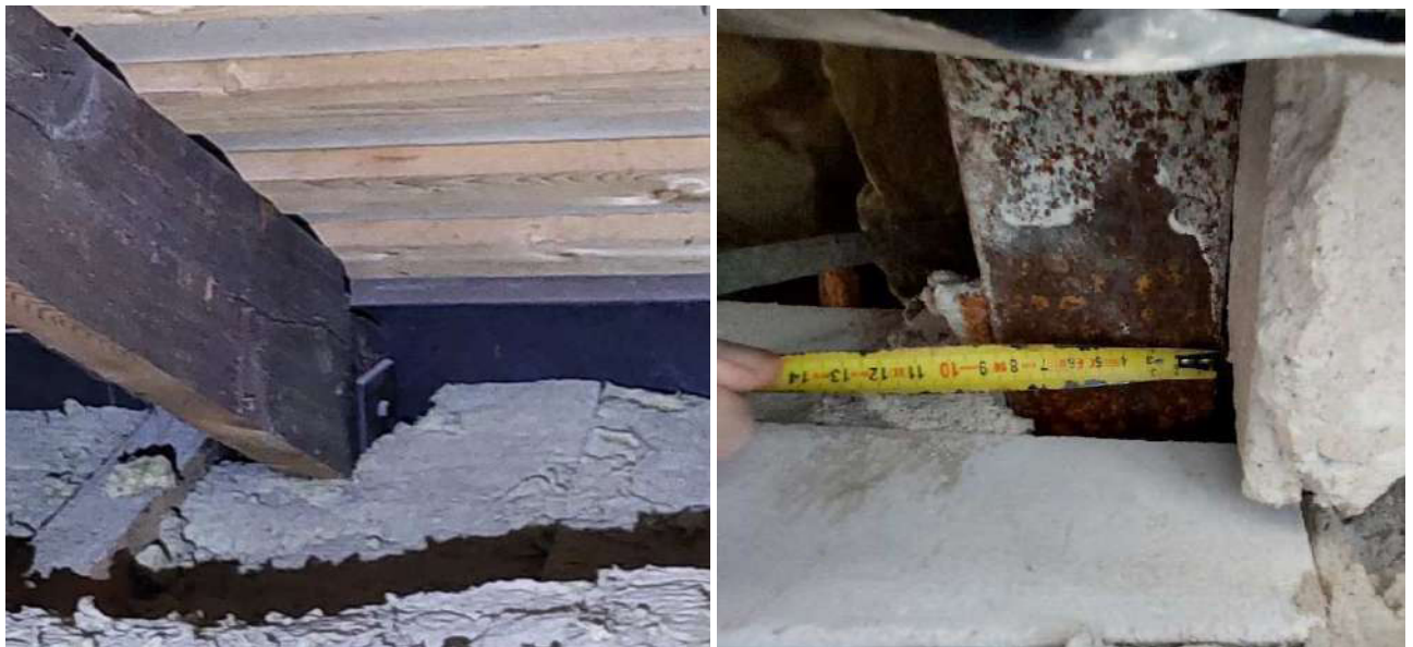
21 pav. Esamos, pradinio projekto stogo plieninės sijos įrengtos šiltinimo sluoksnyje , nepakankamai apsaugotos, paveiktos korozijos
