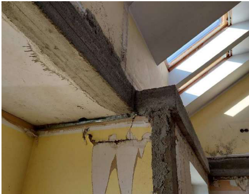
16 pav. 3 aukšto patalpos perdangų demontavimo metu išilgai nukirstos plokštės balkonų zonoje. Palikti siauri perdangos ruožai su išilginiais plyšiais. Zona „D“
