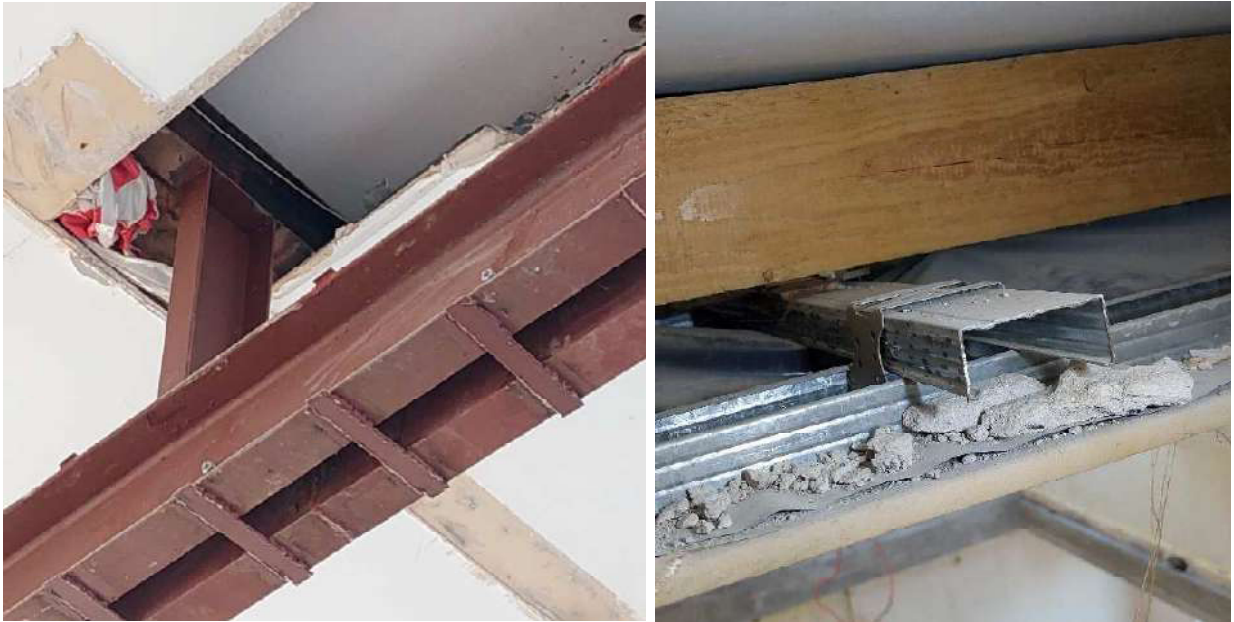
20 pav. Pastogės kapitalinio remonto metu įrengta atrama pastogės plieninei sijai . Demontuotų mūrinių vėdinimo kanalų vietoje liko neapšiltintos lubų zona, neįrengtas lubų karkasas
