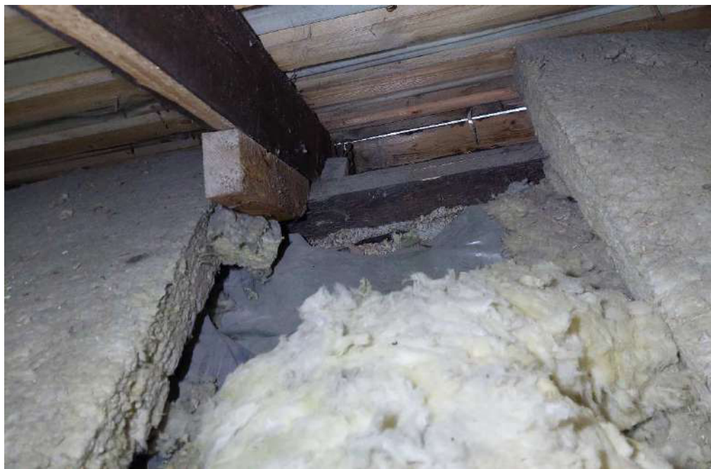
9 pav. Pastogės šiltinimo vaizdas karnizo zonoje, virš balkono plokštės. Šiltinimo plokštės suklotos netvarkingai.
