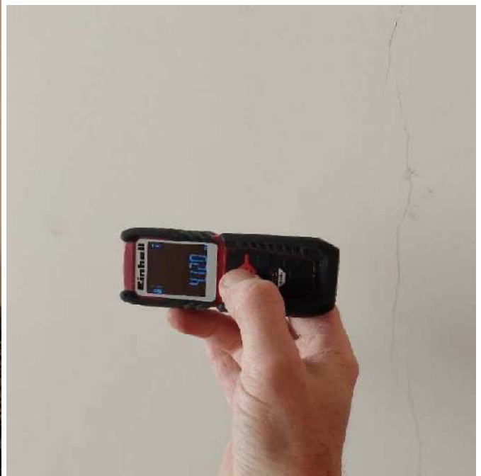
28 pav. 2 aukšto sienų vertikalūs plyšiai
