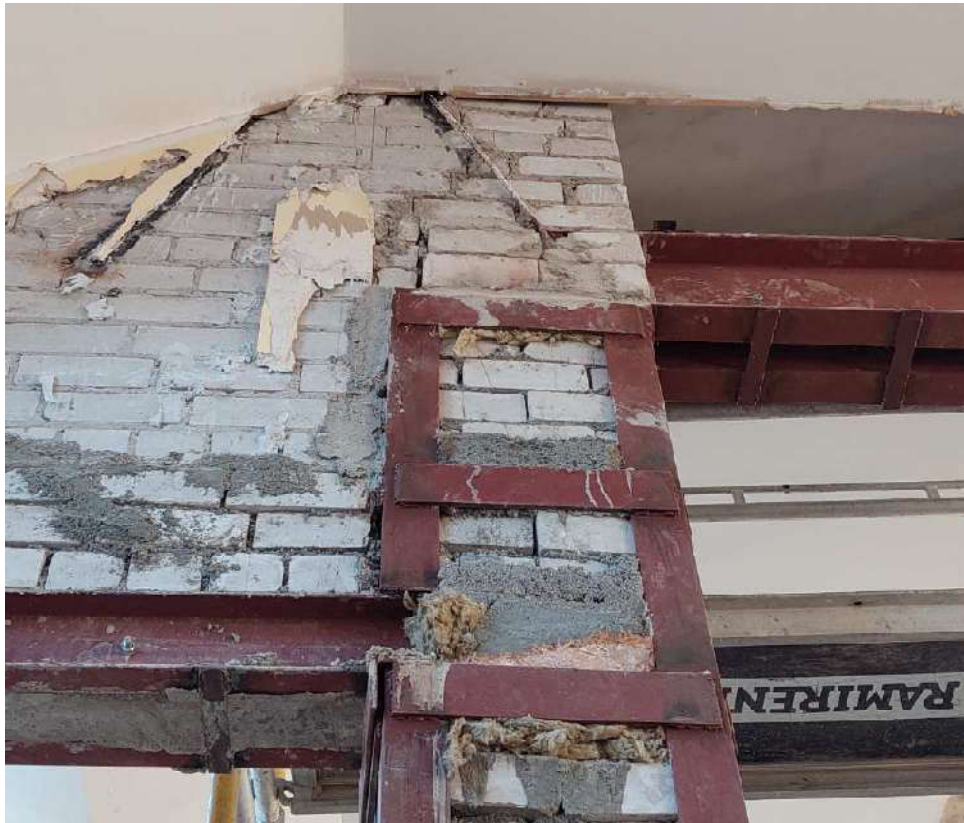
24 pav. Esamų , pradinio projekto stogo plieninių sijų inkaravimo mazgas
