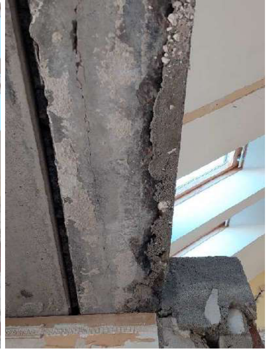
14 pav. 3 aukšto patalpos perdangų demontavimo metu išilgai nukirstos plokštės balkonų zonoje. Palikti siauri perdangos ruožai su išilginiais plyšiais. Zona „B“
