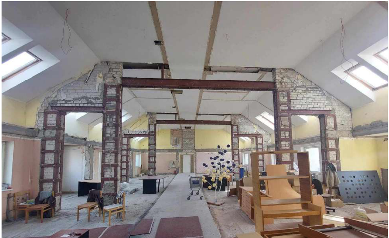
1 pav. Trečio aukšto salės bendras vaizdas su 2013m kapitalinio remonto metu demontuotomis perdangomis ir įrengtomis plieno konstrukcijomis
