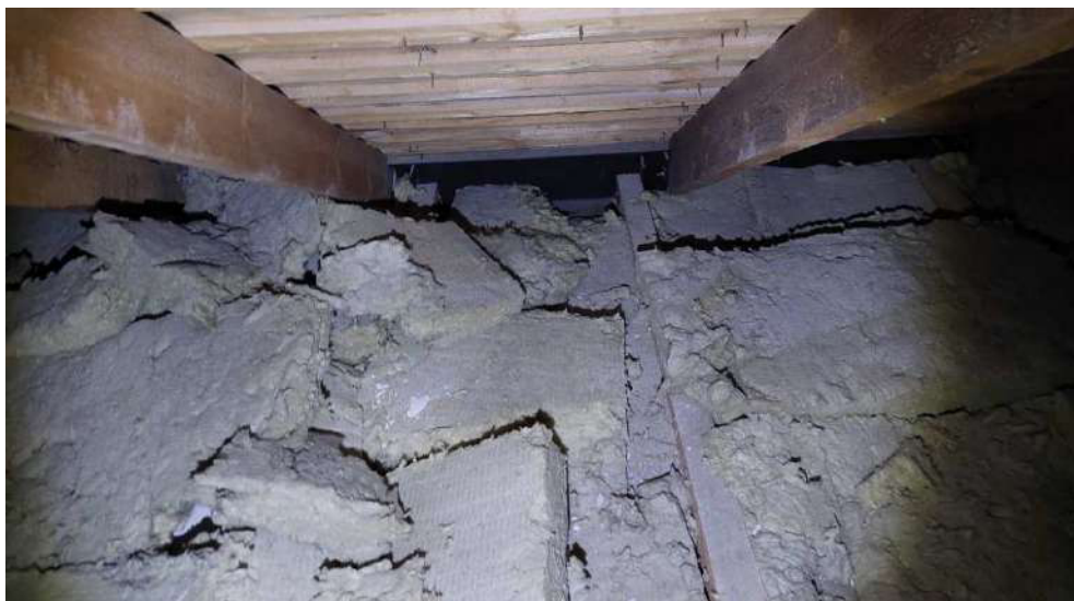
6 pav. Pastogės vaizdas kapitalinio remonto zonoje. Šiltinimo plokštės suktos netvarkingai
