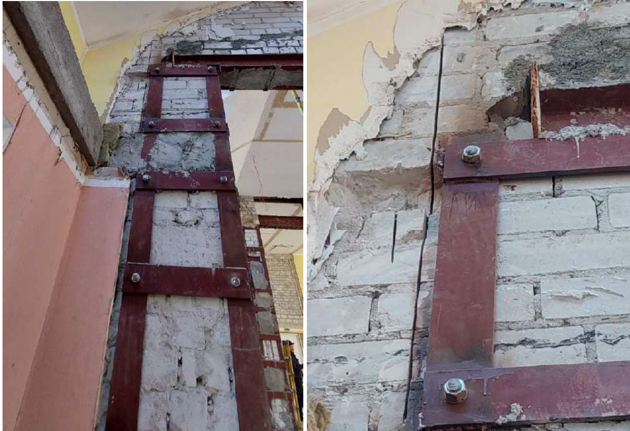
22 pav. Pastogės kapitalinio remonto metu įrengtos plieninės atramos, mūro stulpų aprėminimai. Mūro pjovimo vietose būtina numatyti apkabas surišimui su pagrindine siena
