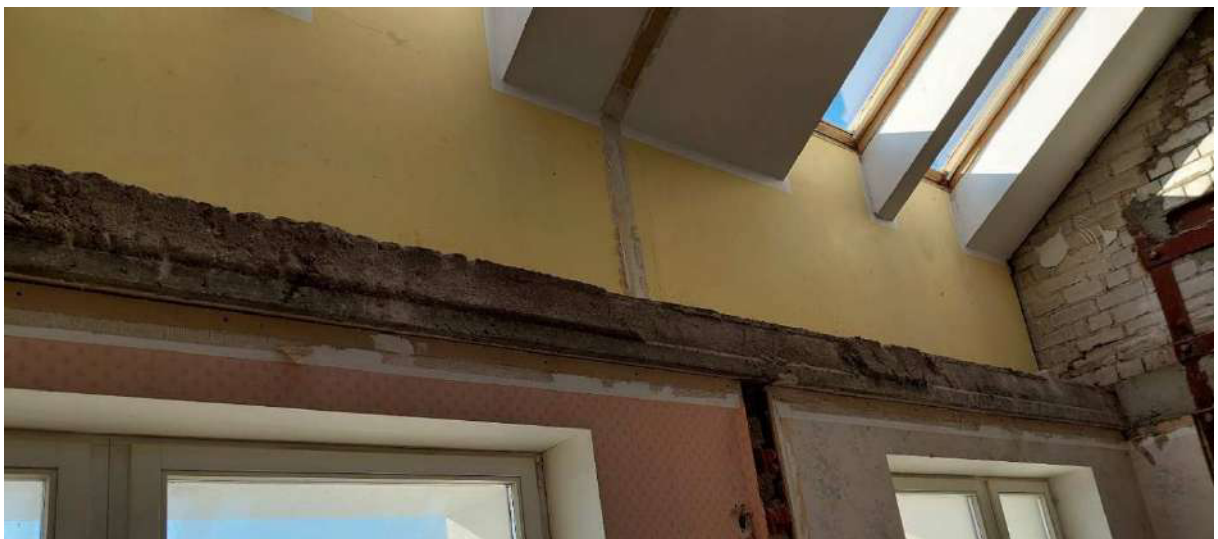
16 pav. 3 aukšto patalpos perdangų demontavimo metu išilgai nukirstos plokštės balkonų zonoje. Palikti siauri perdangos ruožai su išilginiais plyšiais. Zona „D“
