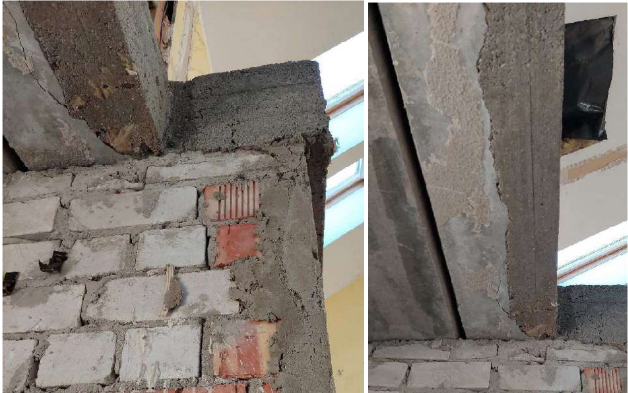
12 pav. 3 aukšto patalpos perdangų demontavimo metu išilgai nukirstos plokštės balkonų zonoje. Palikti siauri perdangos ruožai su išilginiais plyšiais. Zona „A“
