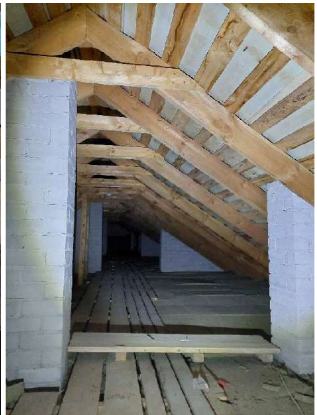
3 pav. Bendras pastogės medinių konstrukcijų vaizdas. Konstrukcijų ir sujungimų būklė gera
