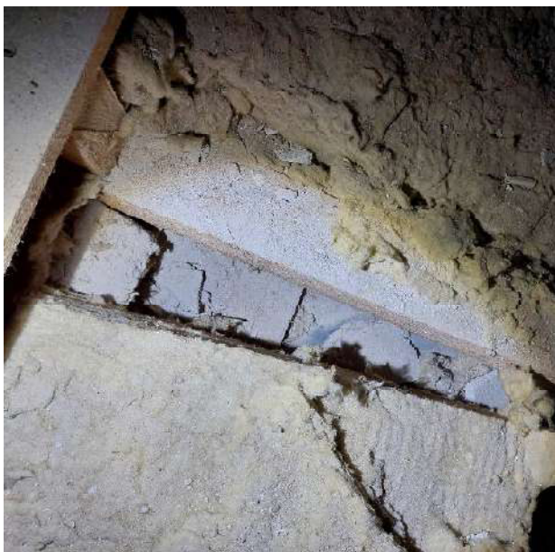
7 pav. Pastogės vaizdas kapitalinio remonto zonoje. Šiltinimo plokštės suktos netvarkingai. Matomi neapšiltinti plotai.
