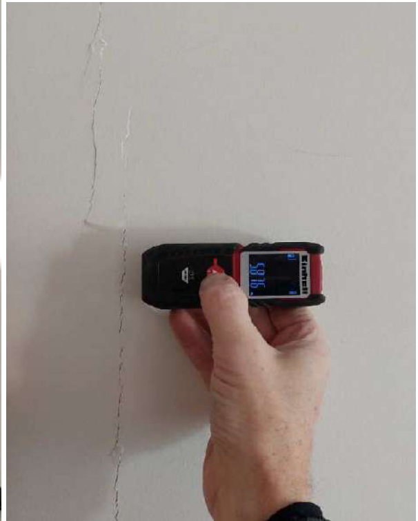
29 pav. 2 aukšto sienų vertikalūs plyšiai
